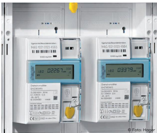
Ein Smart Meter ist ein intelligenter vernetzter, digitaler Stromzähler, der den Energieverbrauch misst und die Energiezufuhr steuert. Er kann zum Last- und Einspeisemanagement ausgebaut werden. Bei Verbrauchern und Stromerzeugern unter den gesetzlich vorgeschriebenen Verbrauchs- bzw. Erzeugungsgrenzen können Smart Meter freiwillig eingebaut werden.
